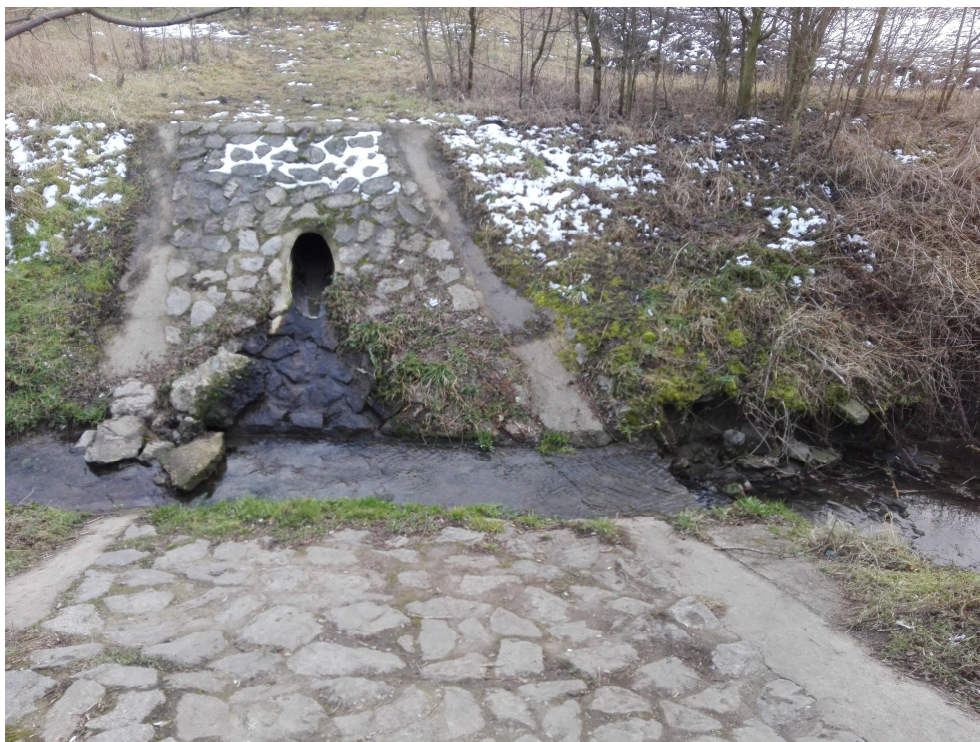
Foto č. 43 Pohled na opevnění výusti ČOV v ř. km 7,306 - 7,309
