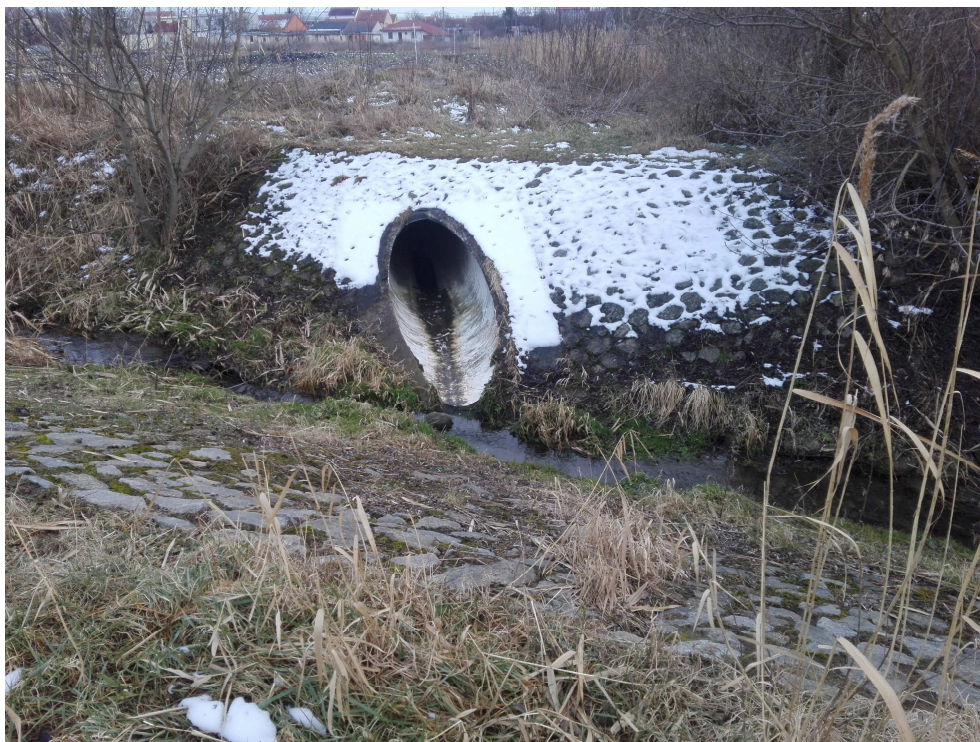
Foto č. 49 Pohled na výúst' odlehčovací komory v ř. km 7,430
